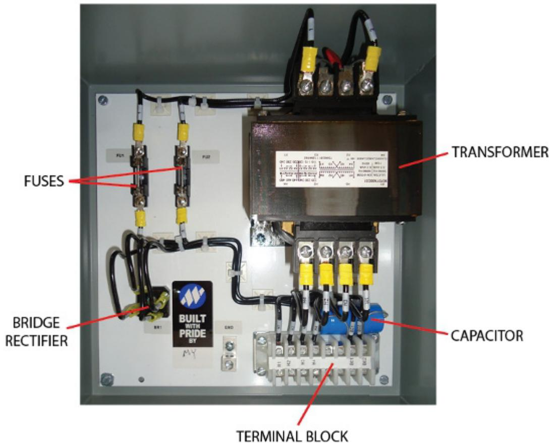
**Figure 1: Brake Rectifier**
